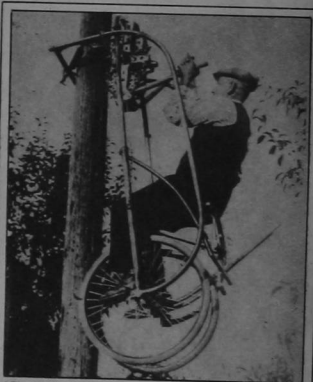
Aparato inventado por Herr Kutt de Frankfurt, Alemania, para subir a los árboles o postes telegráficos.
